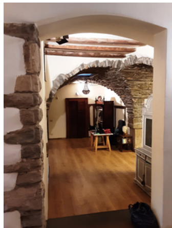
4. Via Roccolino, spigolo di muratura lavorato a bisello sull'angolo sud-occidentale della struttura.
