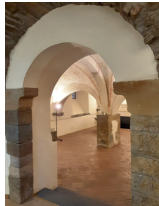
11. Via Roccolino, varco di entrata sul lato sud.
