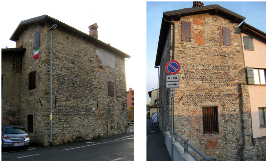
12, 13. Bergamo, torre di via Radini Tedeschi, già nelle pertinenze del castrum dei Bonghi a Redona.
